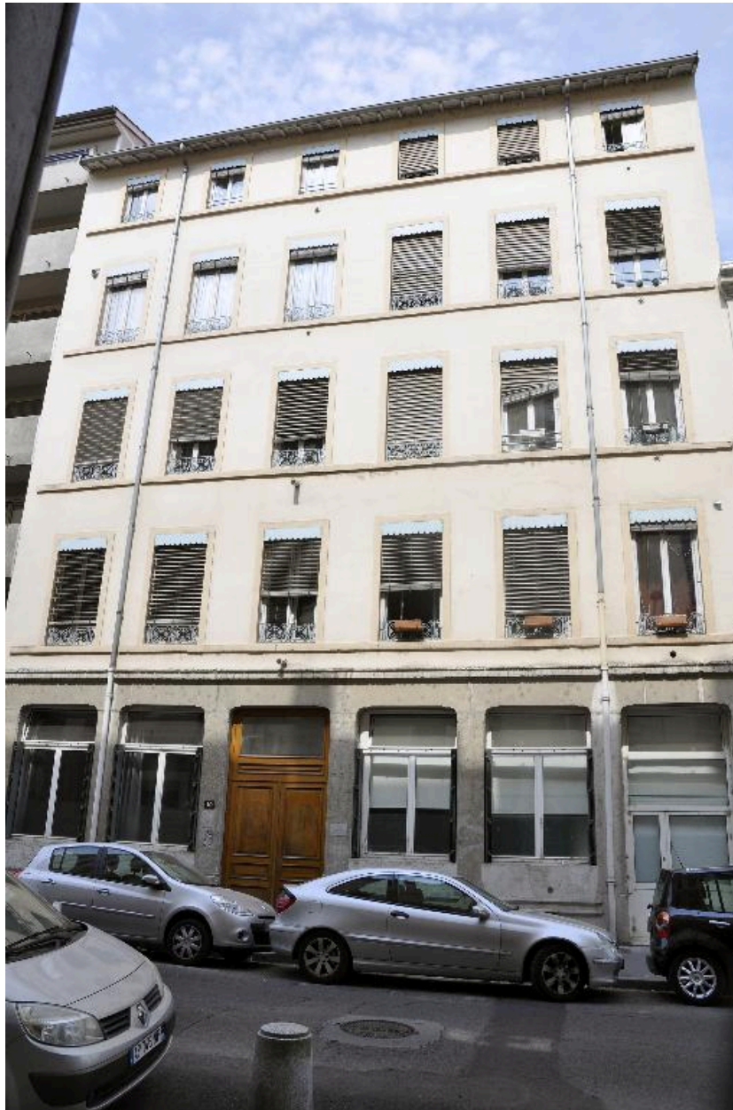
Vue générale de l'élévation sur rue
