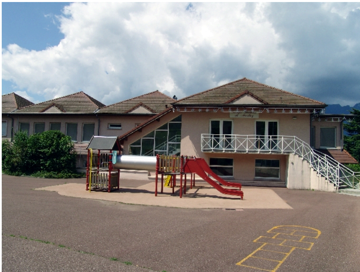
Façade est, détail
