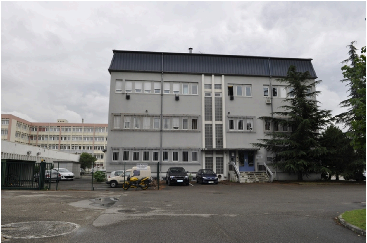
Bâtiment abritant la transmission, façade nord.
