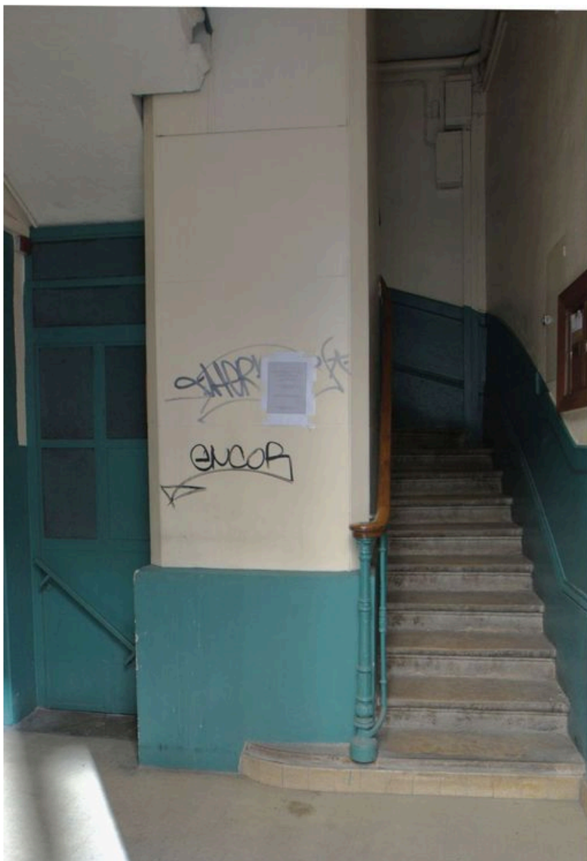
Vue de la première volée de l'escalier
