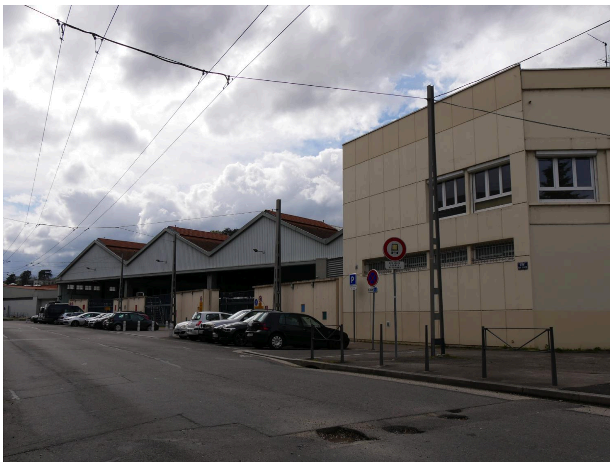
Vue nord du dépôt
