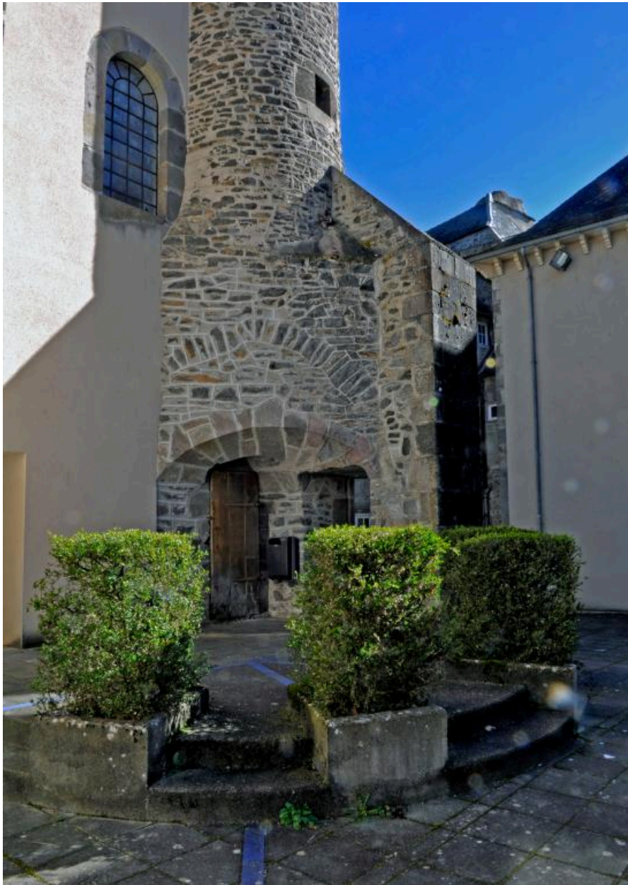
Base de la tour d'escalier menant au comble
