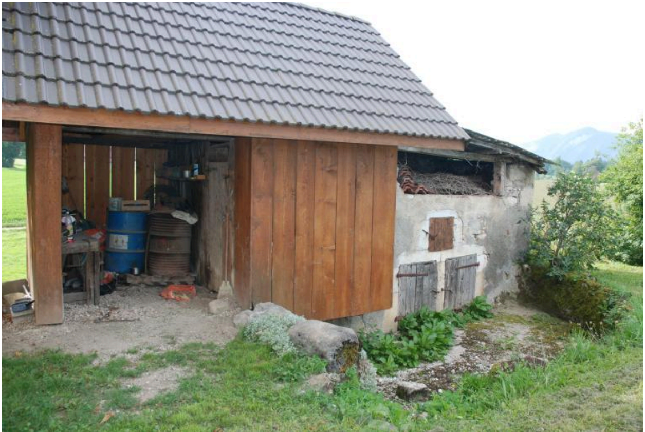
Vue d'ensemble du bâtiment abritant cochons et poules.
