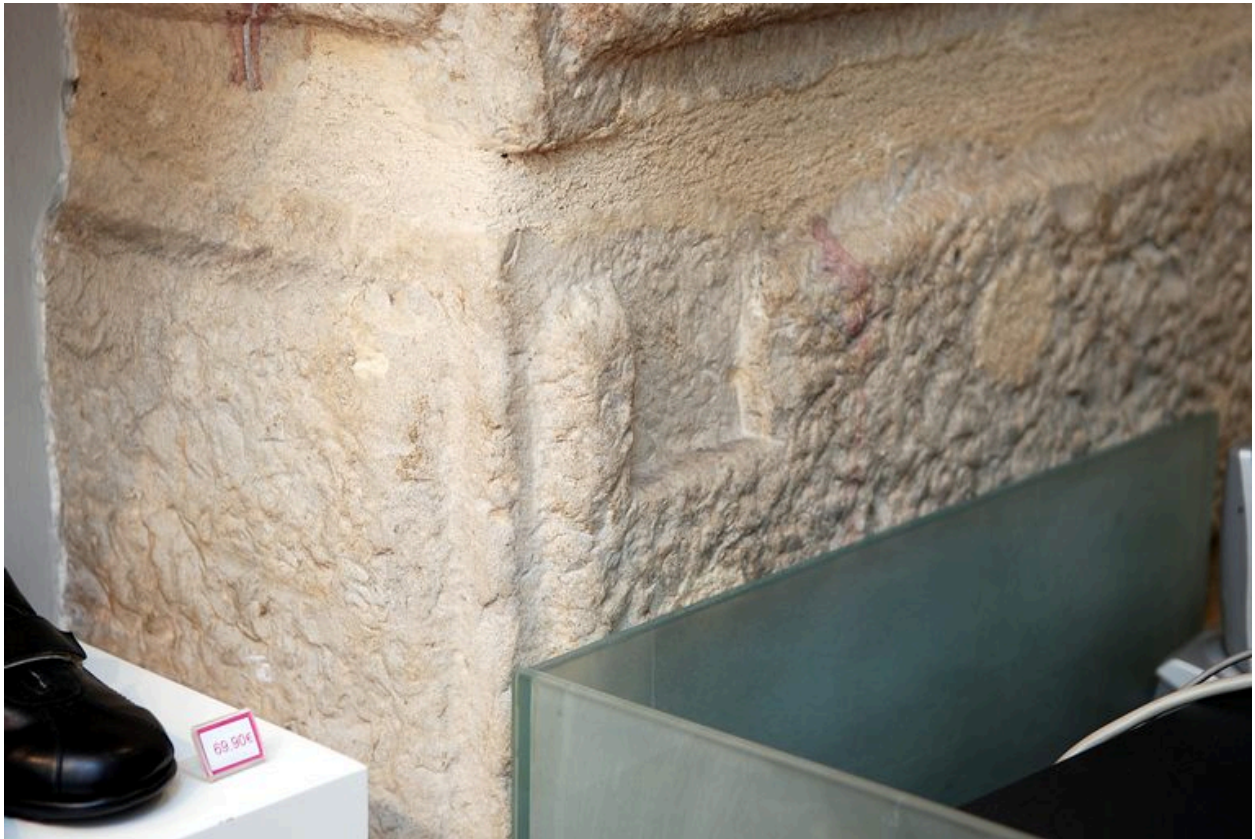
Intérieur ouest : pilier du XVIIe, encoche
