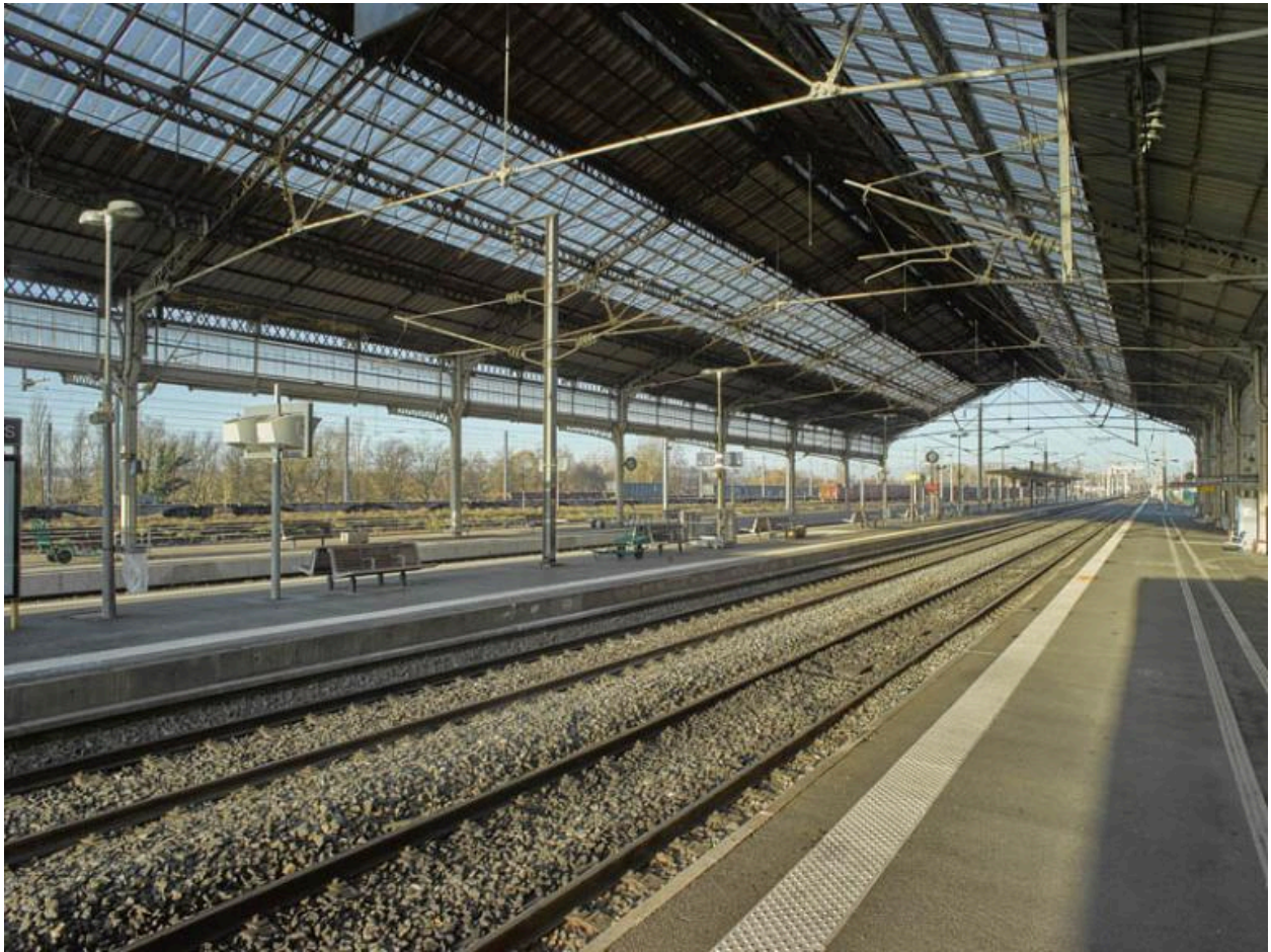
Détail de la grande halle à structure métallique et verrières au-dessus des quais de la gare de Saint-Germain-des-Fossés.
