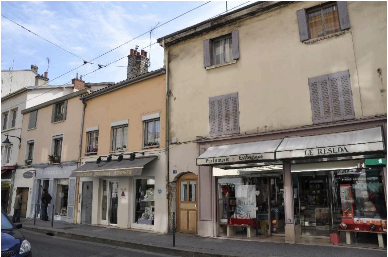
Vue d'ensemble sud ouest de l'immeuble d'un étage
