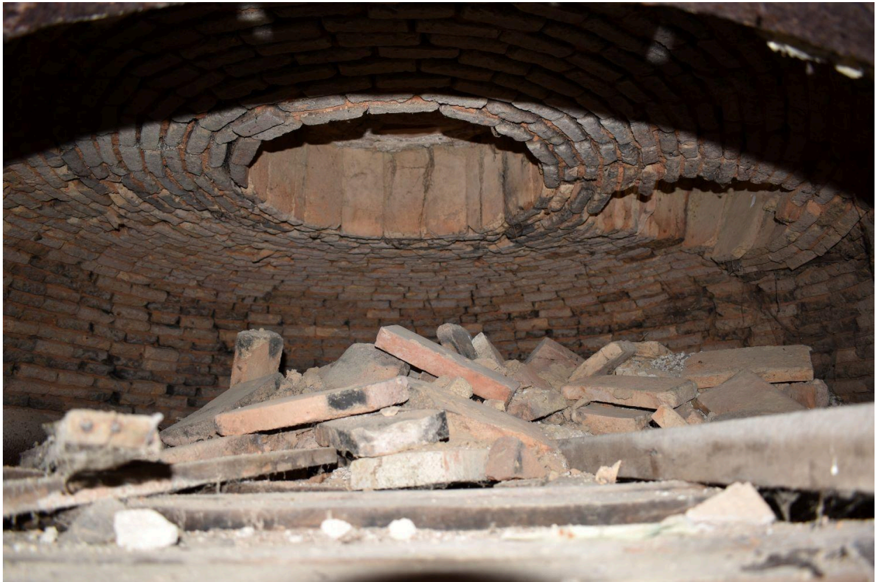
Vue de la voute de briques du four.
