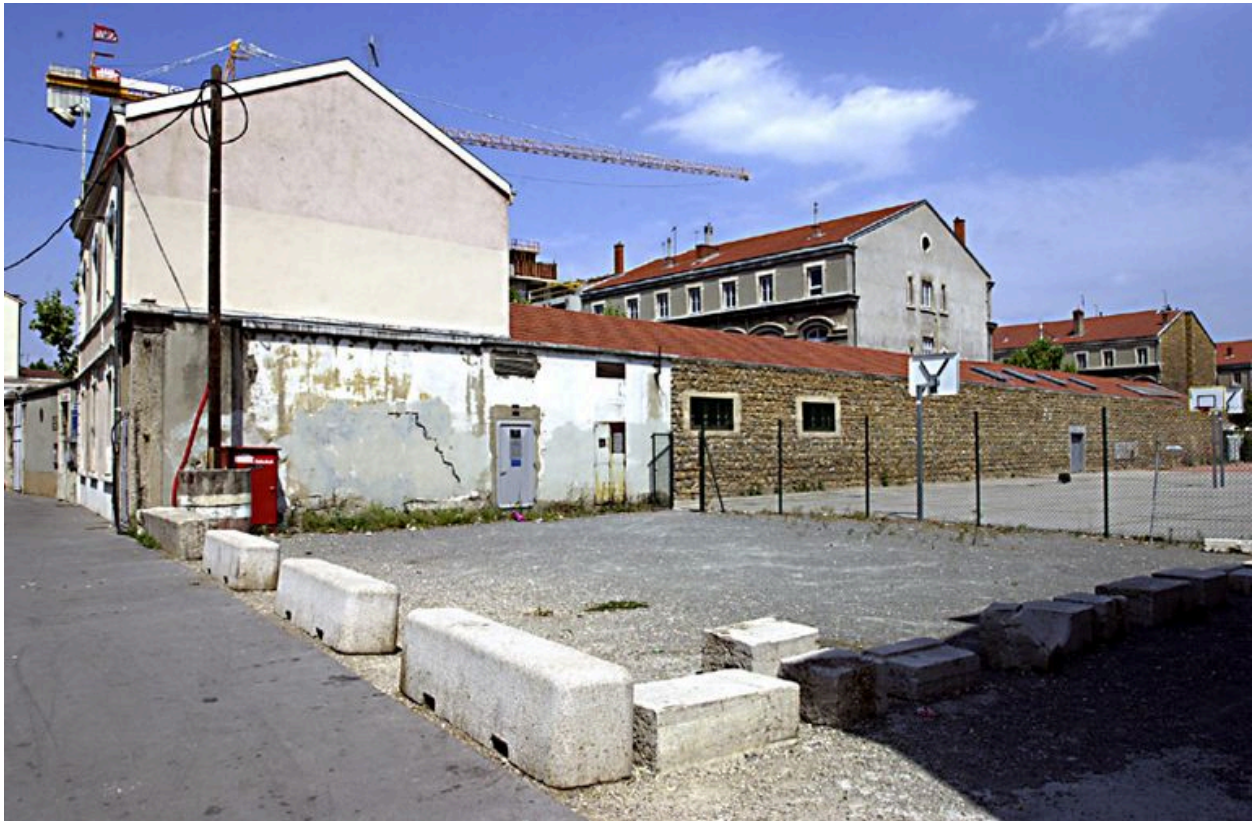
Vue d'ensemble de l'élévation latérale est du groupe scolaire depuis la rue du Béguin
