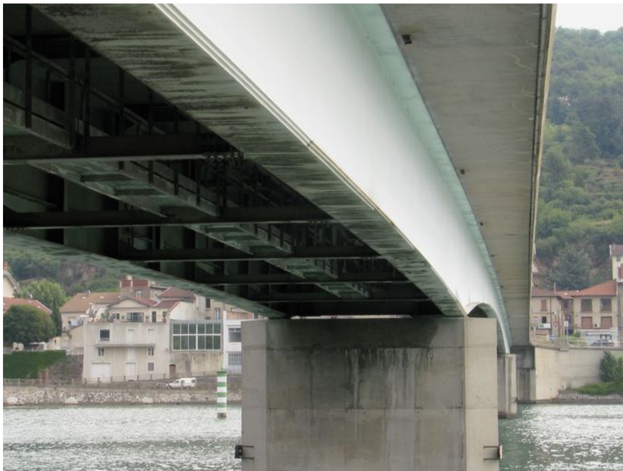
Vue partielle, de côté, dessous du tablier, face aval (depuis la rive droite)
