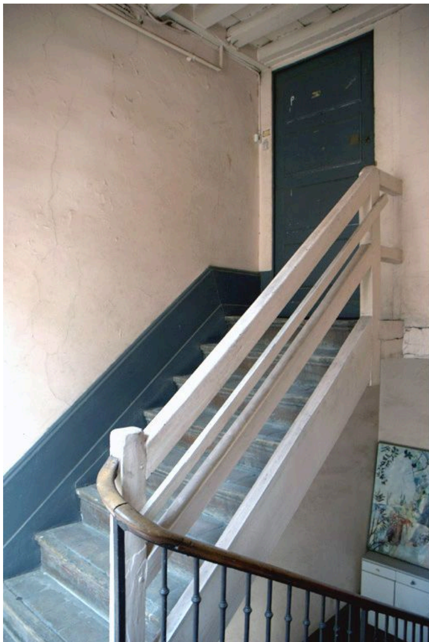
Dernière volée de l'escalier
