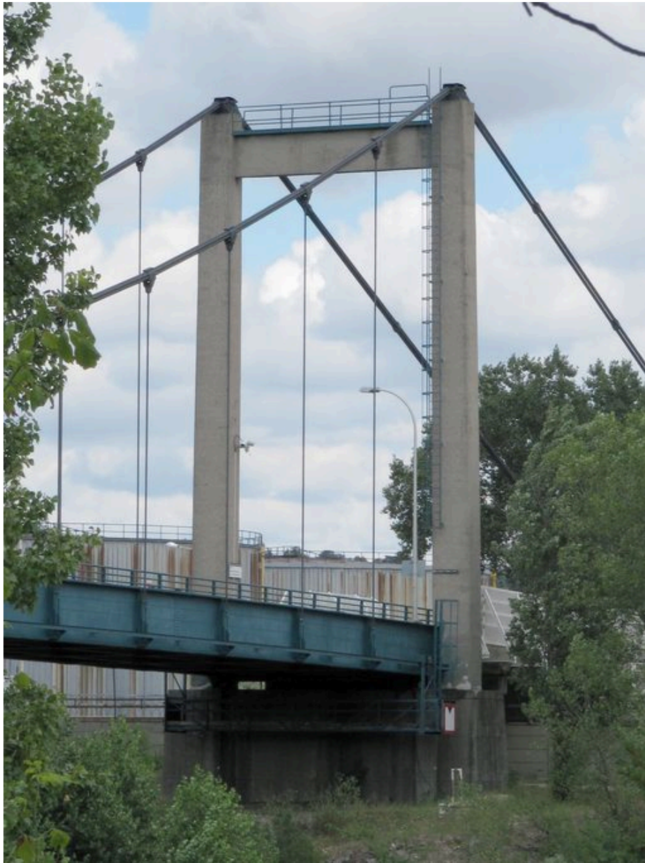
Pylône de la rive gauche (depuis la rive droite)
