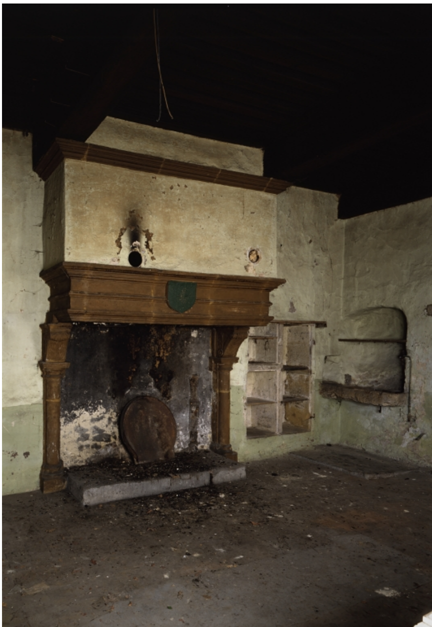
Salle du logis A, vue d'ensemble de l'aménagement : cheminée, placard de pierre, évier.
