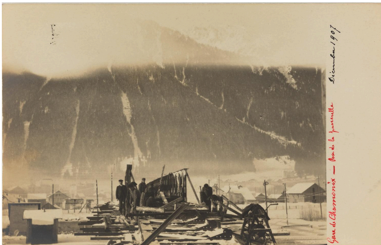
Gare de Chamonix, montage de la passerelle. 1907 (AD Haute-Savoie : 36 Fi 538)
