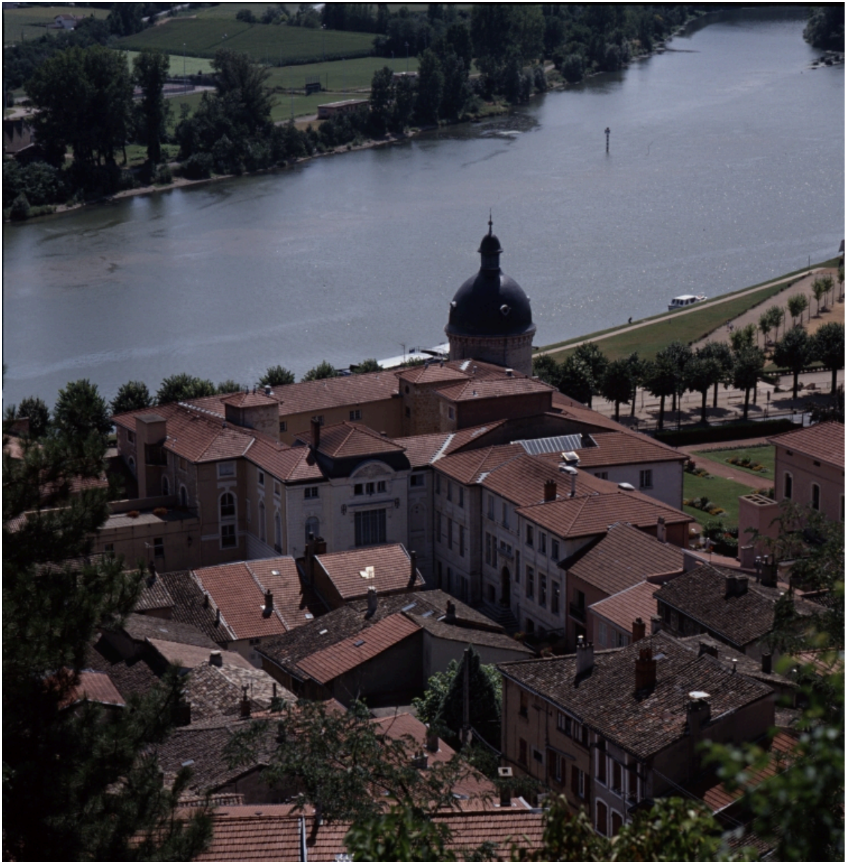
Vue partielle de l'hôpital, depuis le nord est.
