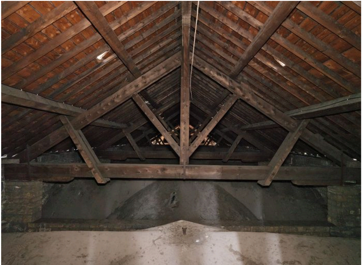
Vue de la charpente surmontant le vaisseau central.
