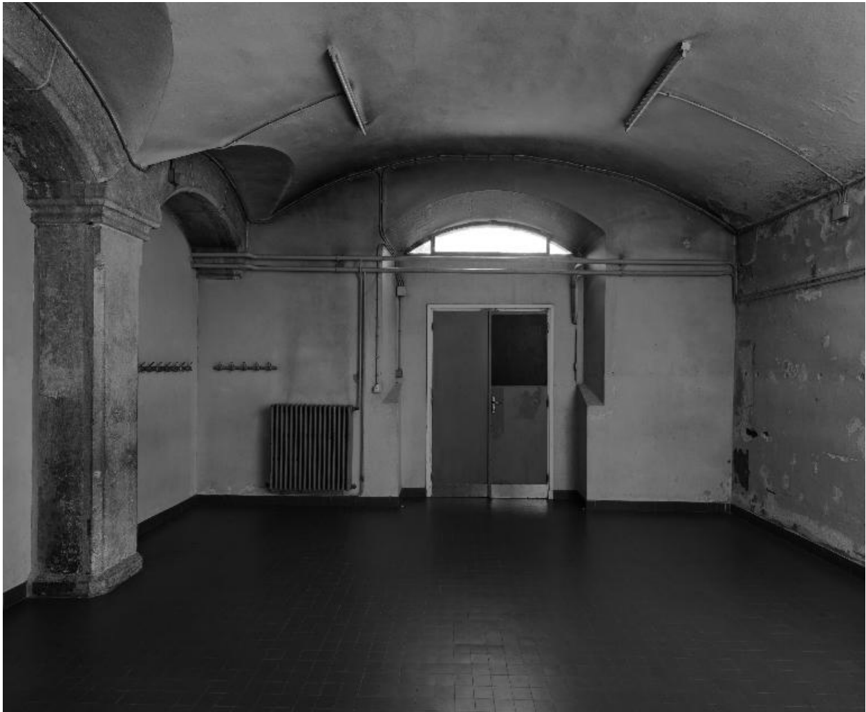
Corps de bâtiment nord-est, étage de soubassement : 2e salle voûtée, autre vue
