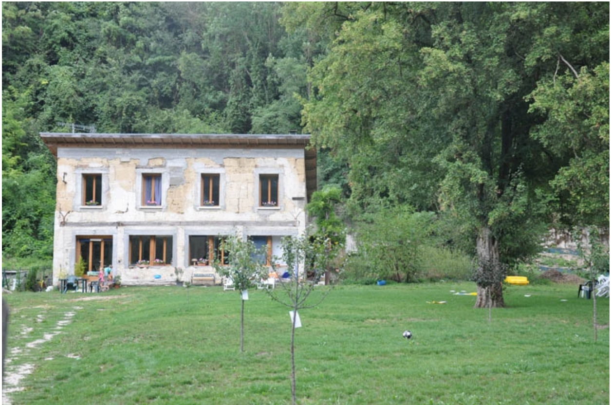
Vue générale du bâtiment de l'ancienne scierie, façade sud
