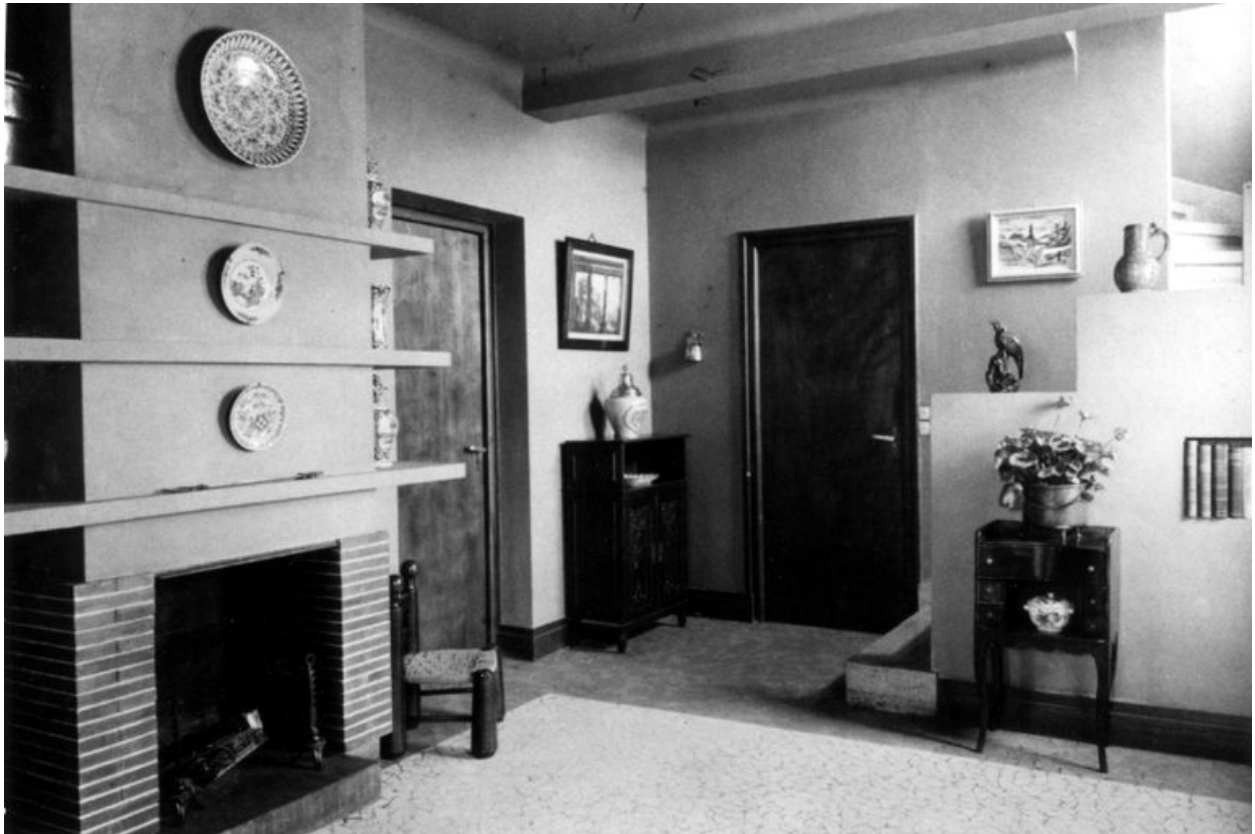
Le hall, la cheminée et le départ de l'escalier. Photograph., [vers 1935] (Dossier agence n° 112)
