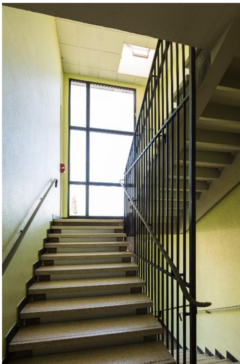
Escalier : bâtiment nord
