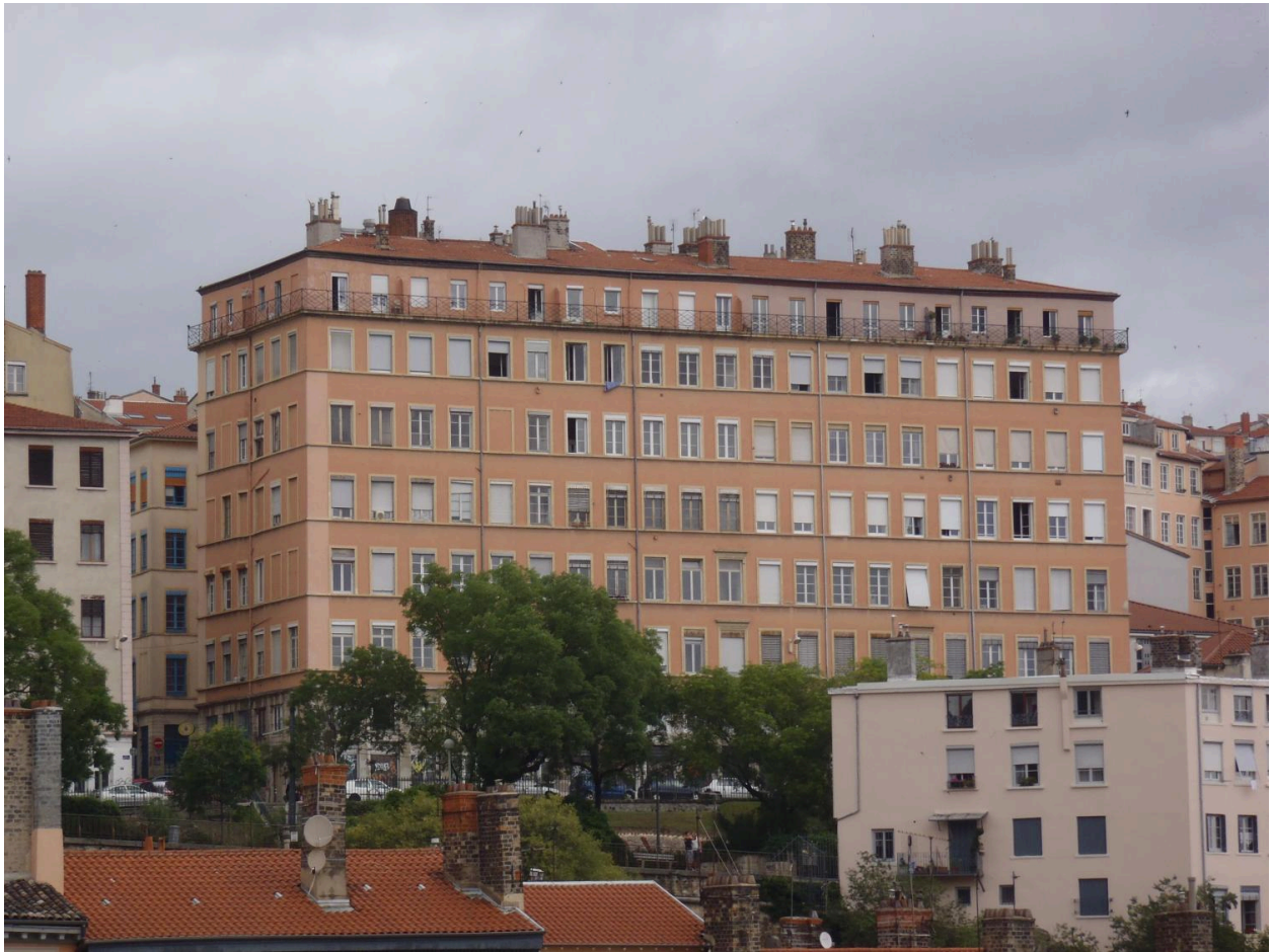
Vue d'ensemble de l'immeuble Brunet
