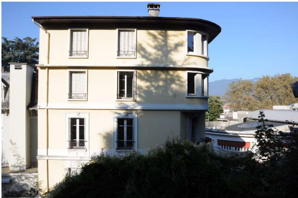
Vue partielle de la façade postérieure (façade est)
