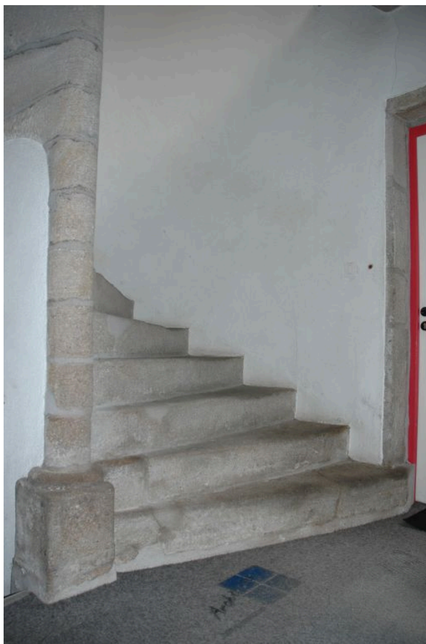
Départ de l'escalier en vis, rue Puy de la Bâtie.
