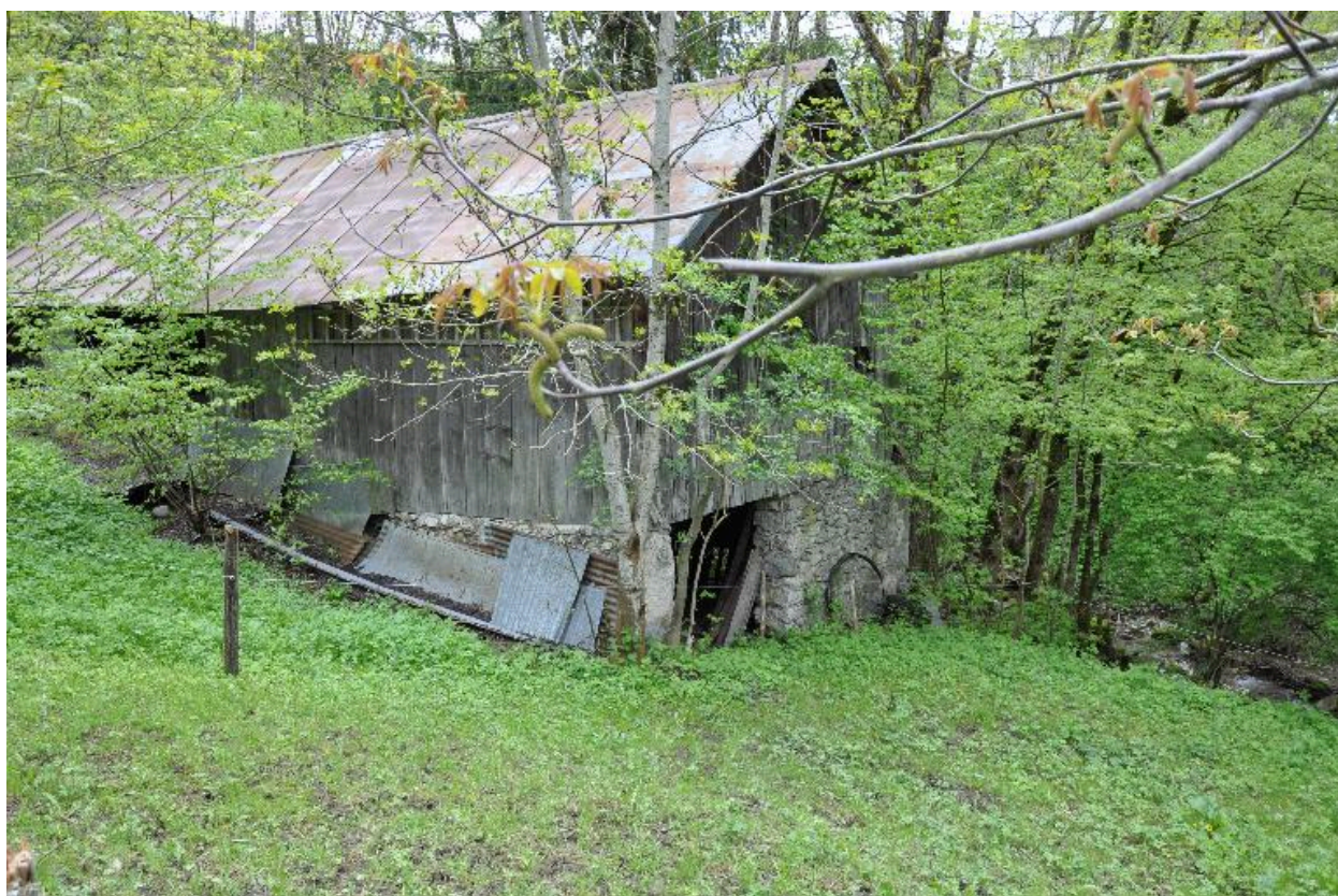
Vue générale de la scierie, pignon est.
