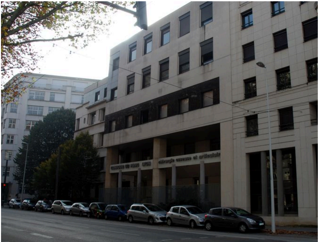
Vue de l'élévation sur le boulevard des Belges.
