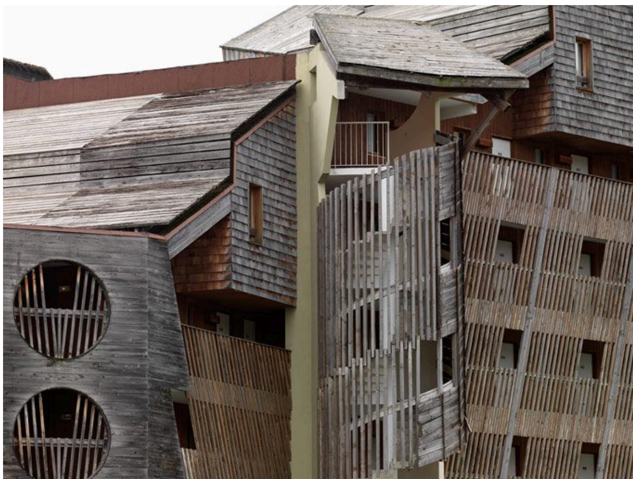
Détail de la façade nord
