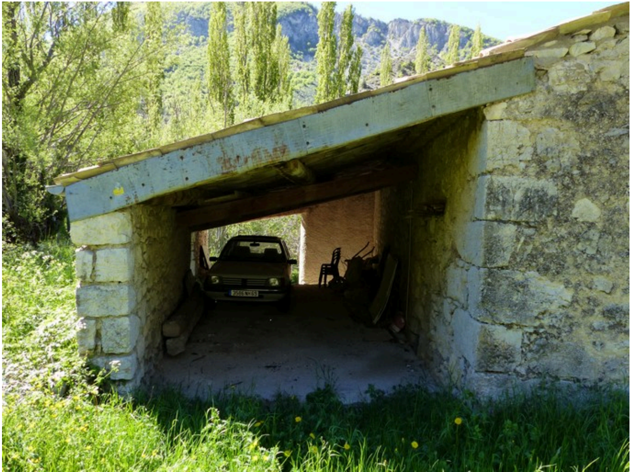
Hangar. Vue d'ensemble prise du nord.
