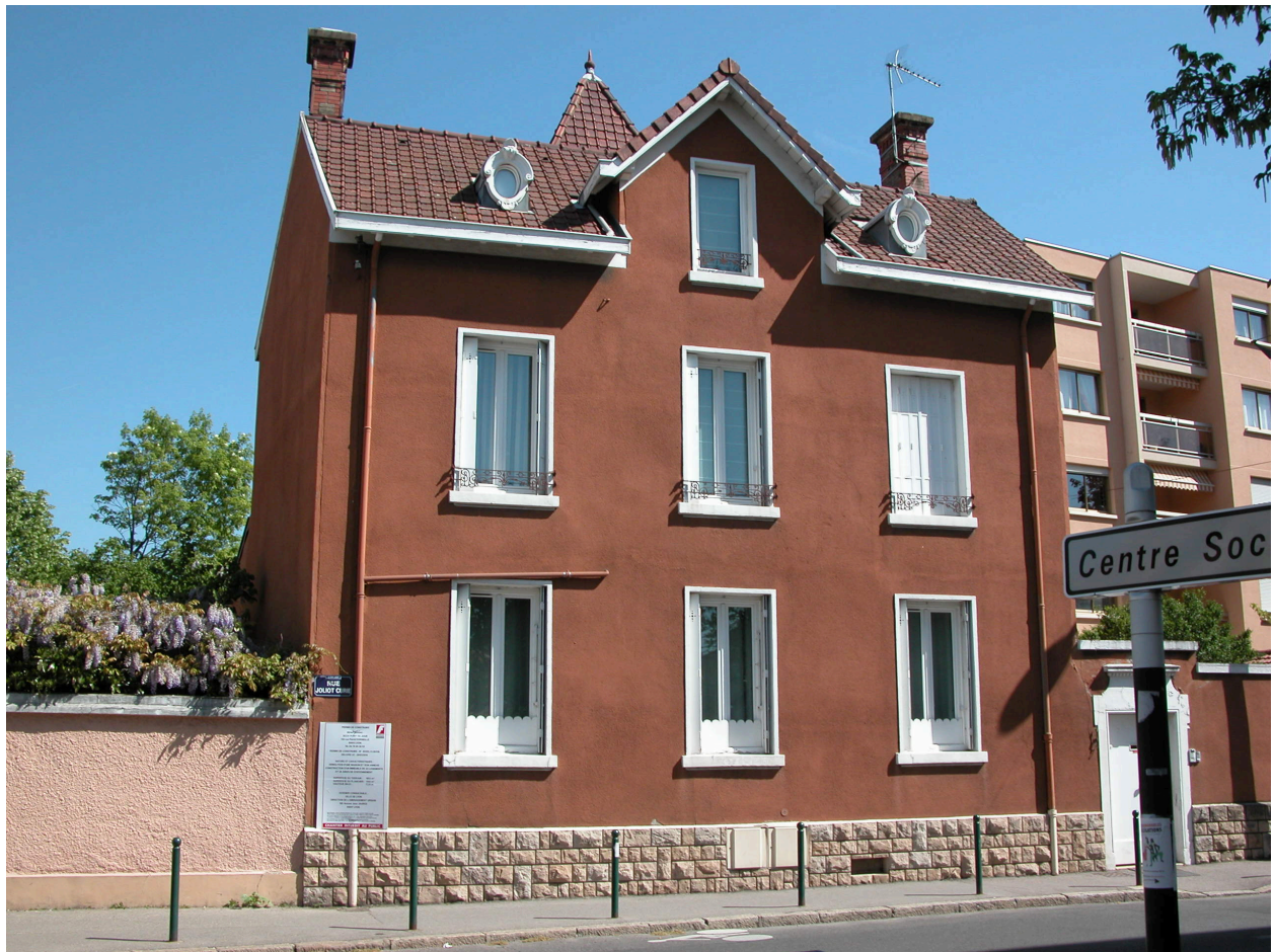
Vue rapprochée de la façade principale
