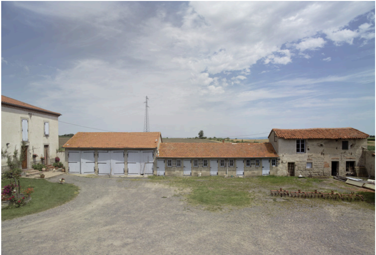
Vue d'ensemble intérieure de la cour : côté nord.
