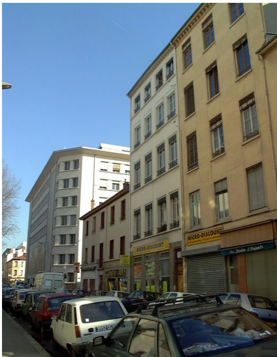
Façade sur rue, vue générale
