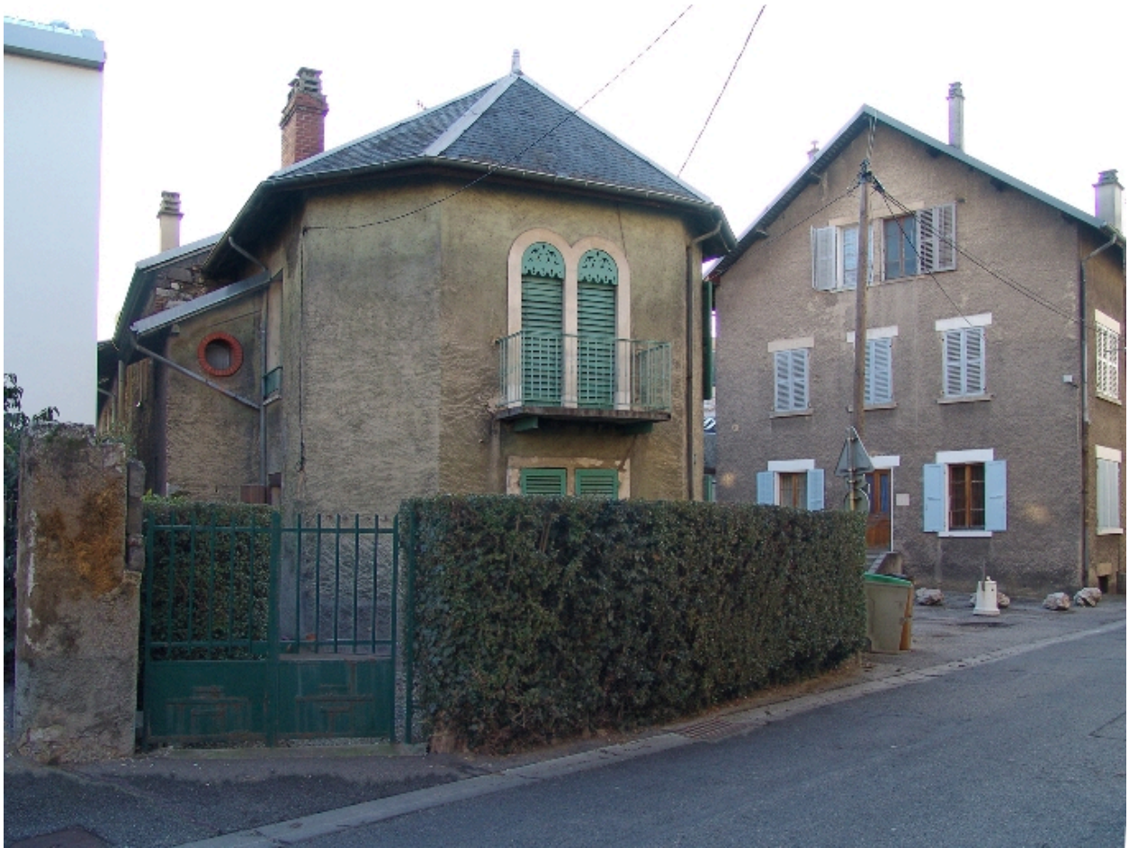
Façade sur cour
