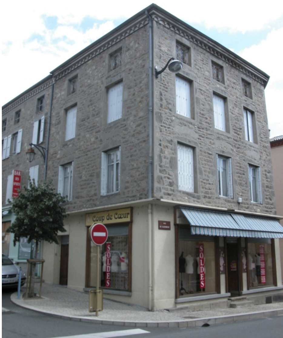
Îlot 1. République (place de la) 05. Vue d'ensemble des façades de la maison
