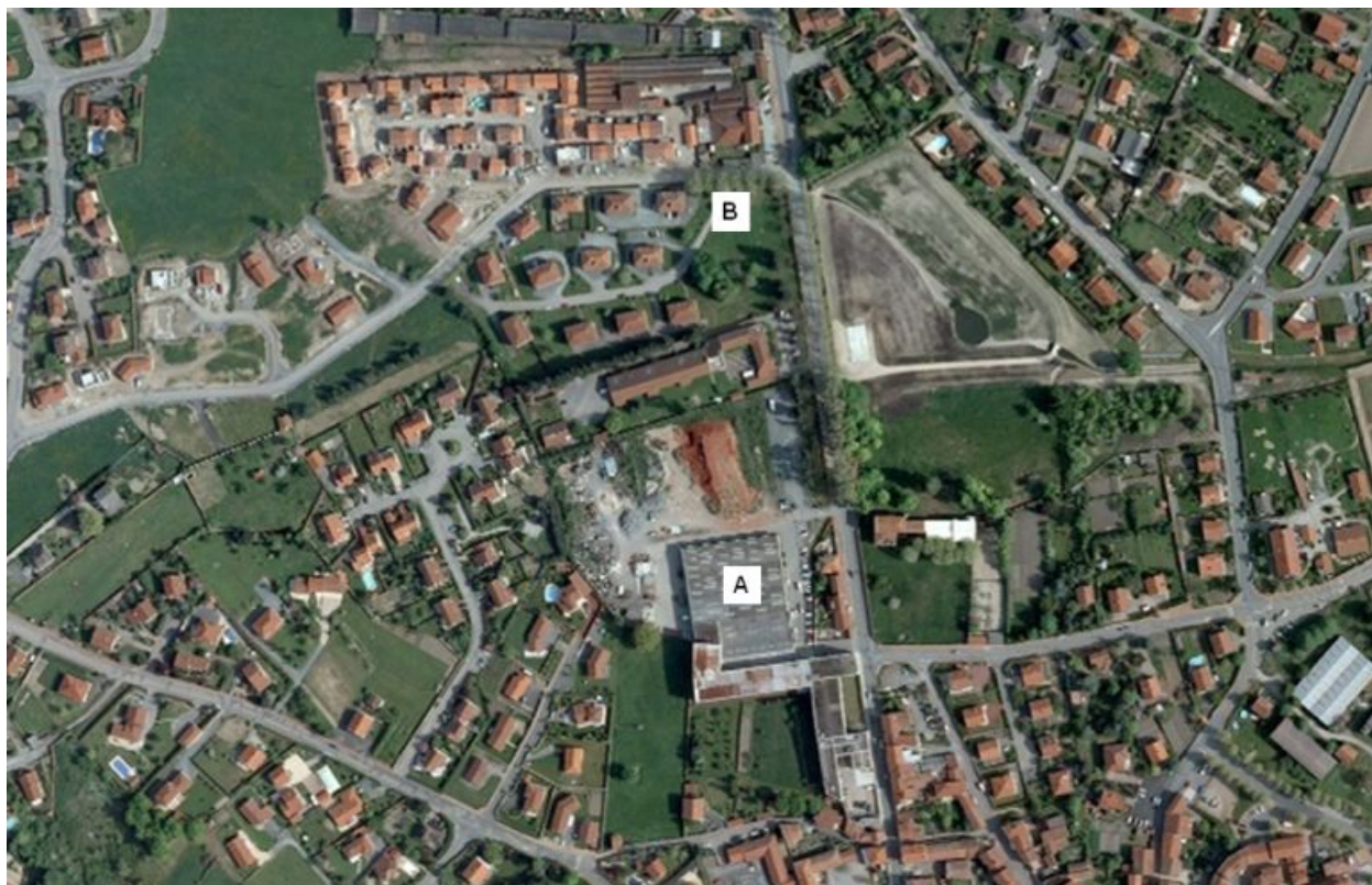
Vue aérienne Mappy du site industriel de GÉGÉ. A : Usine ; B : Cité ouvrière
