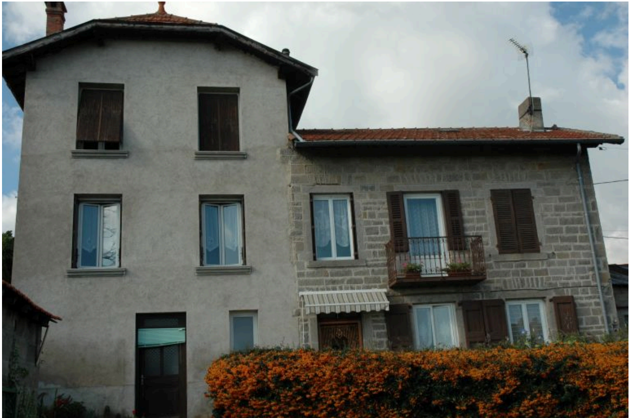
Rigaud, ferme, 1986 AB 323. Vue d'ensemble de la façade principale.
