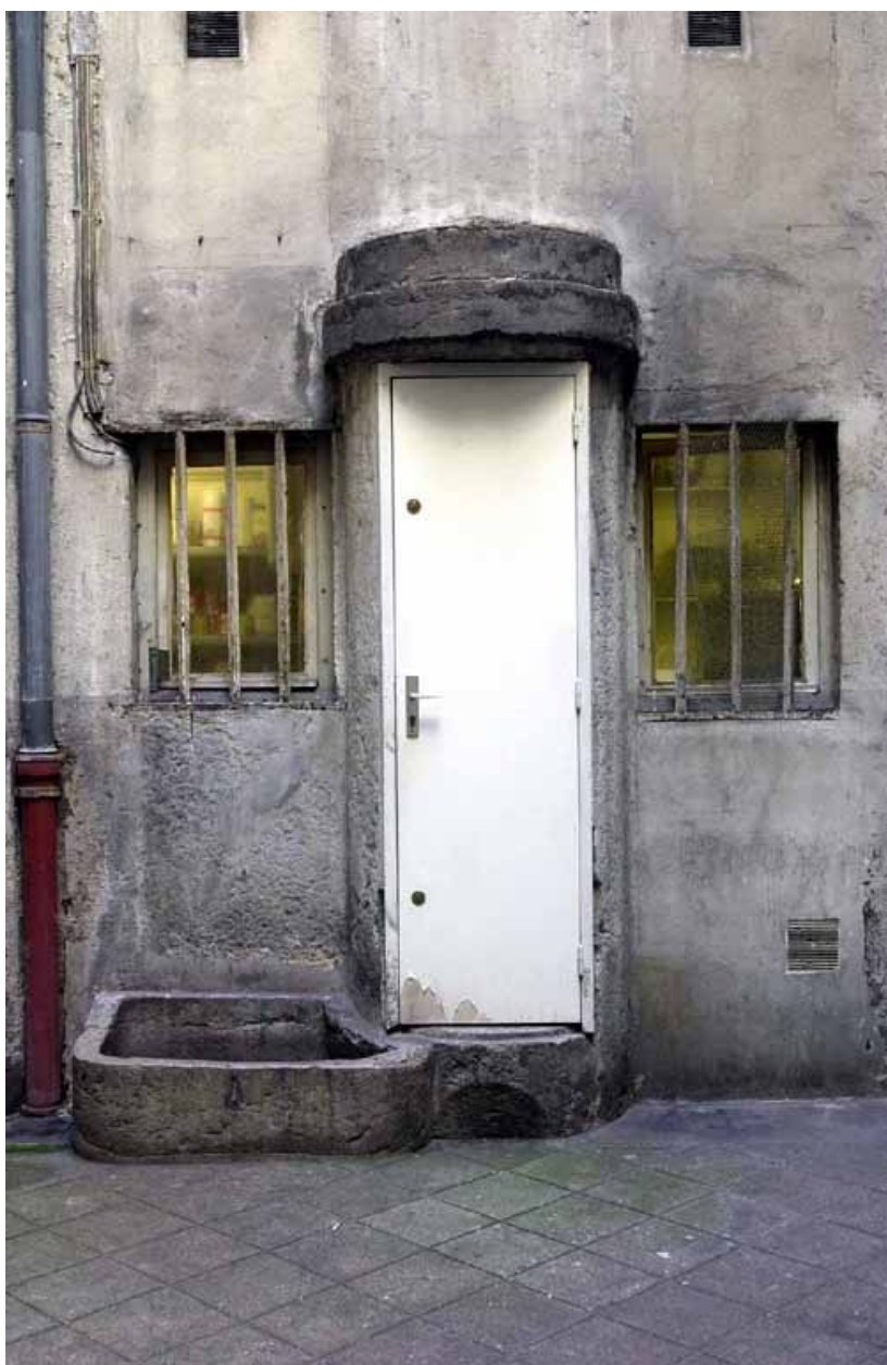
La cour : puits et bassin, rez-de-chaussée, côté sud
