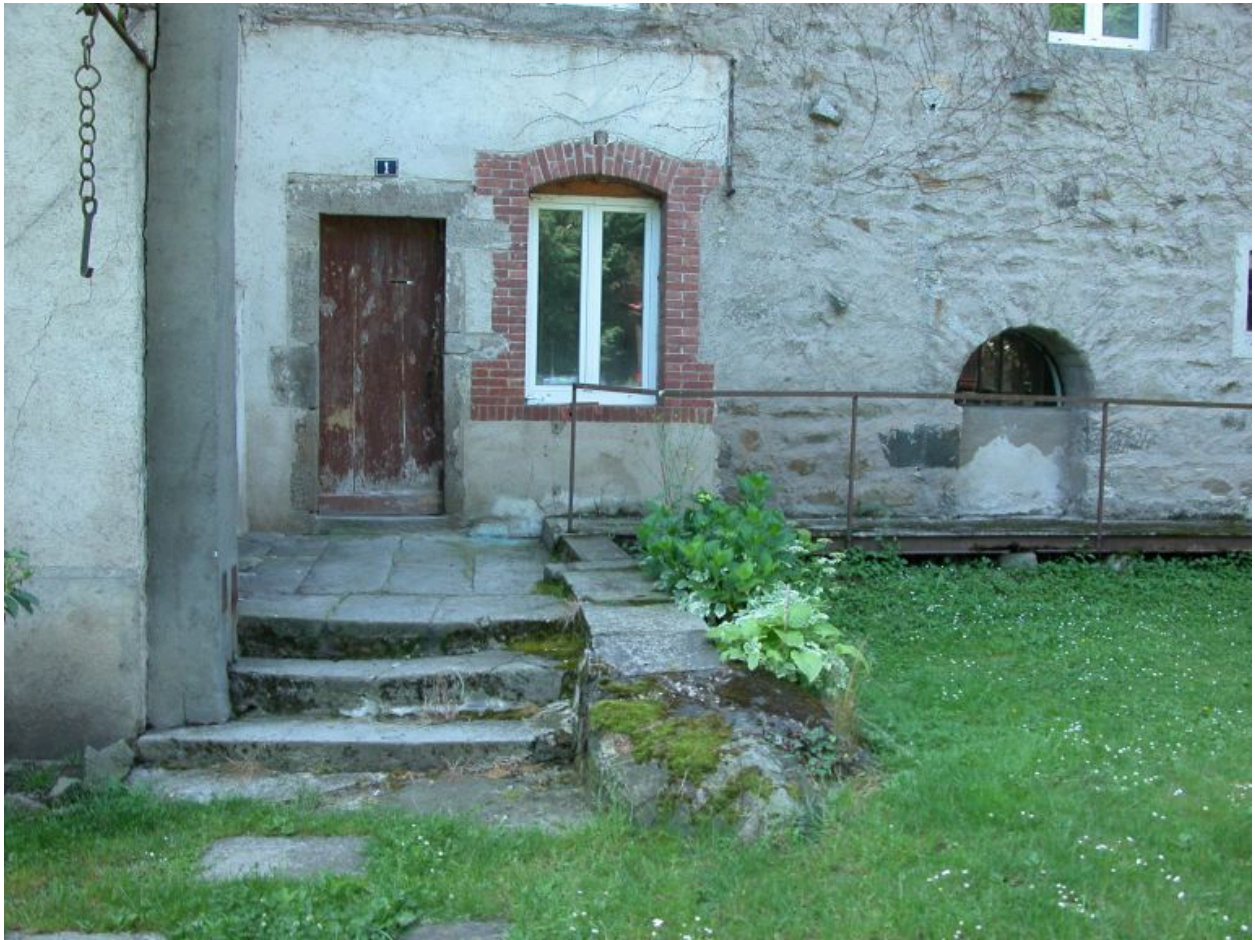
Porte d'accès au second corps de bâtiment, façade nord-ouest du moulin.
