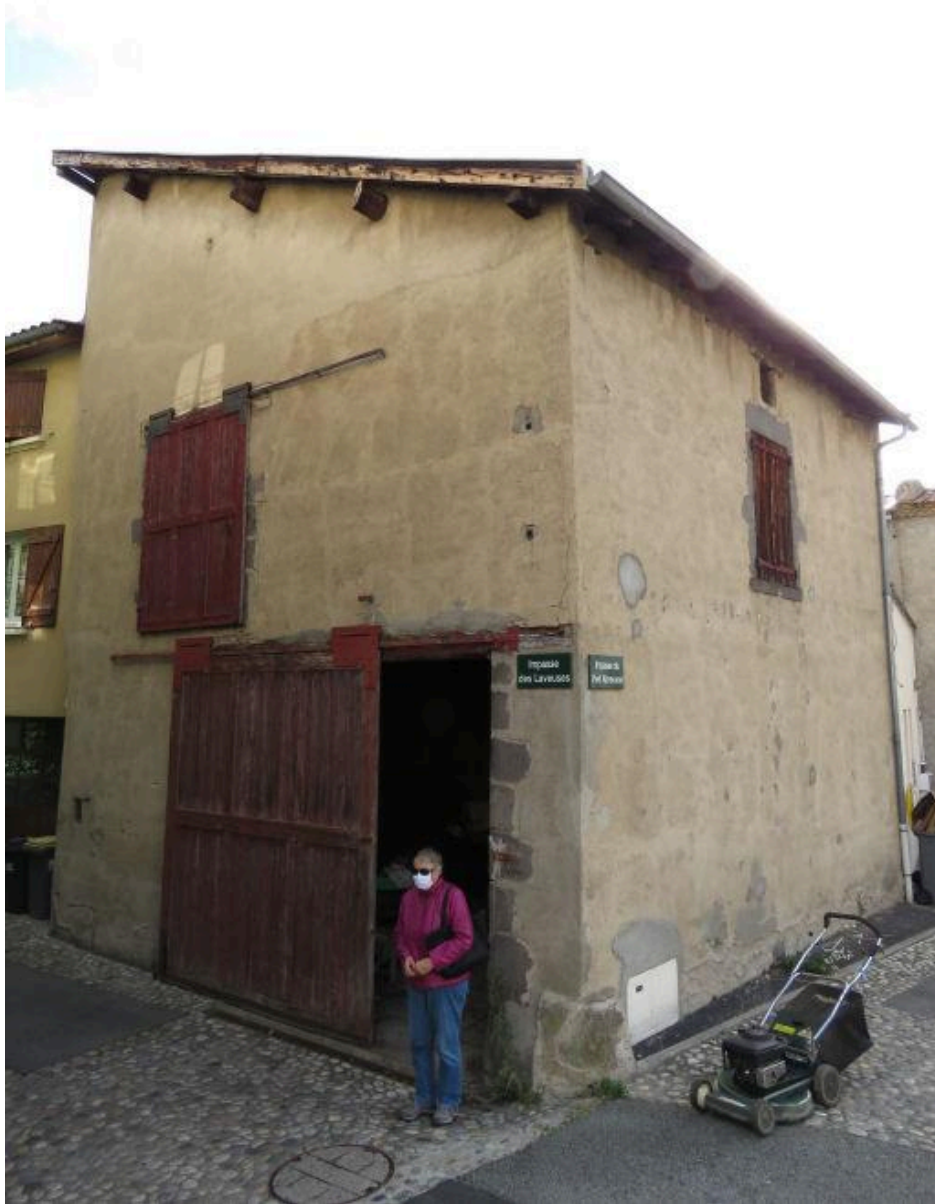
Vue générale du cuvage, indépendant de la maison
