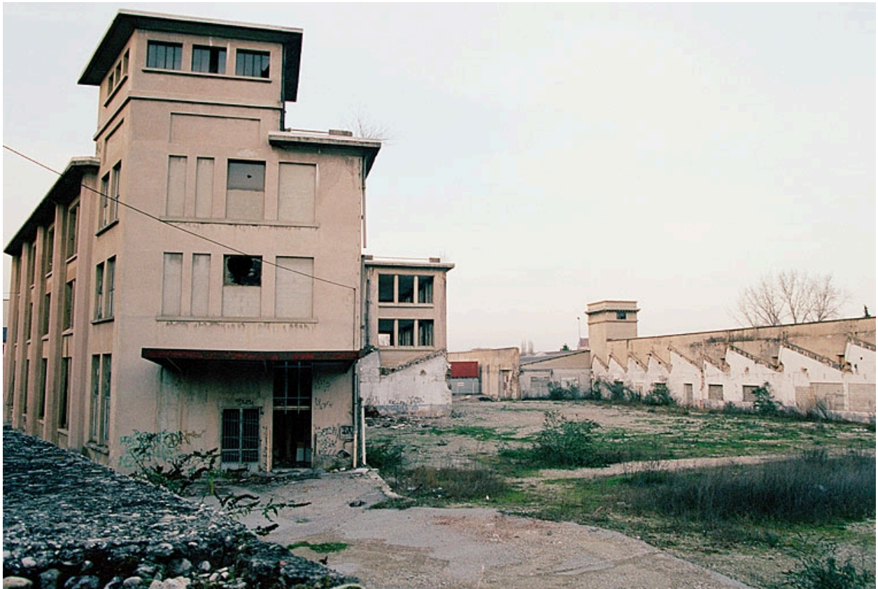
Vue nord, avec traces de shed démoli
