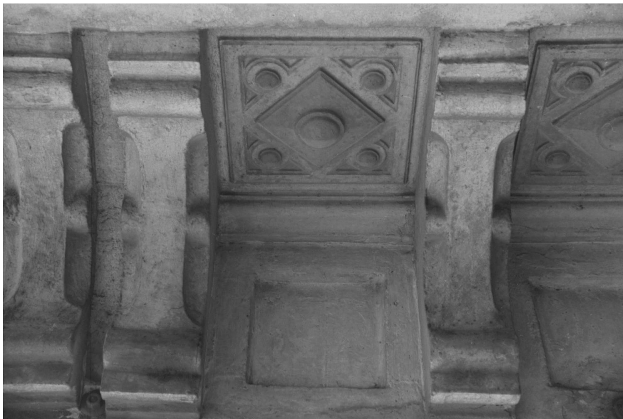
Consoles et métope de la corniche. Métope jaune, bleu et rouge. Pavillon EB, avant-corps, côté nord
