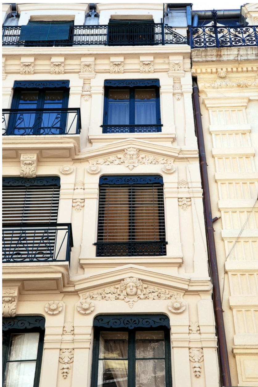
Elévation antérieure : vue partielle
