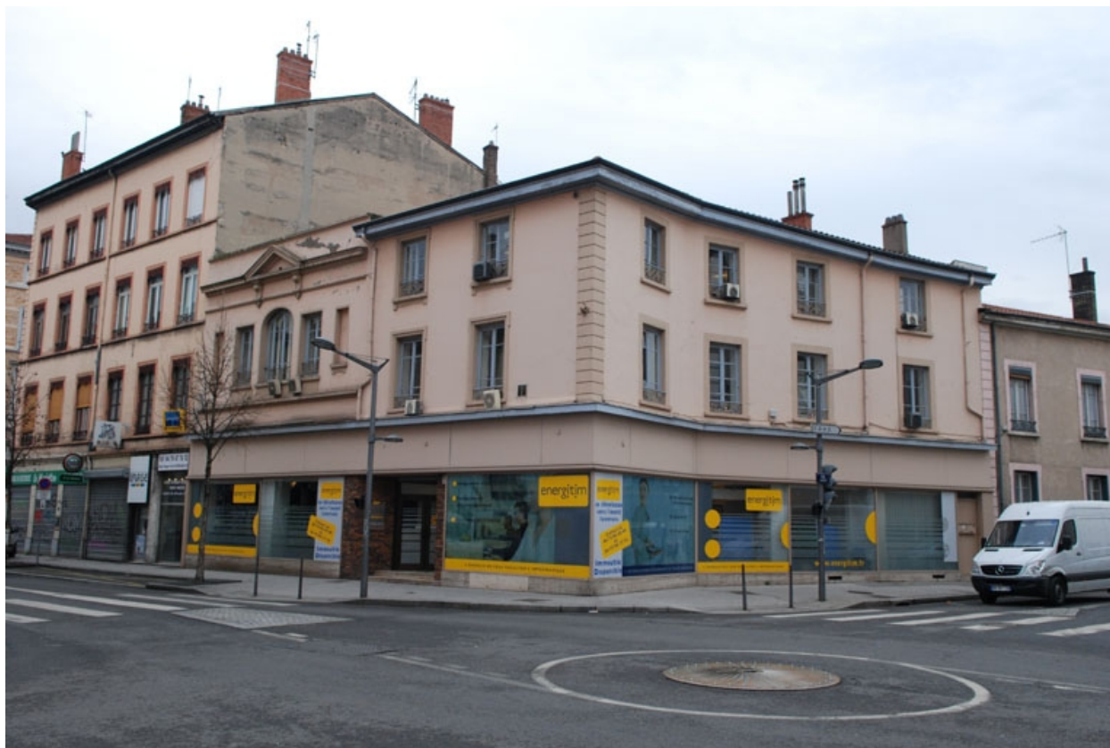
Vue d'ensemble du bâtiment principal
