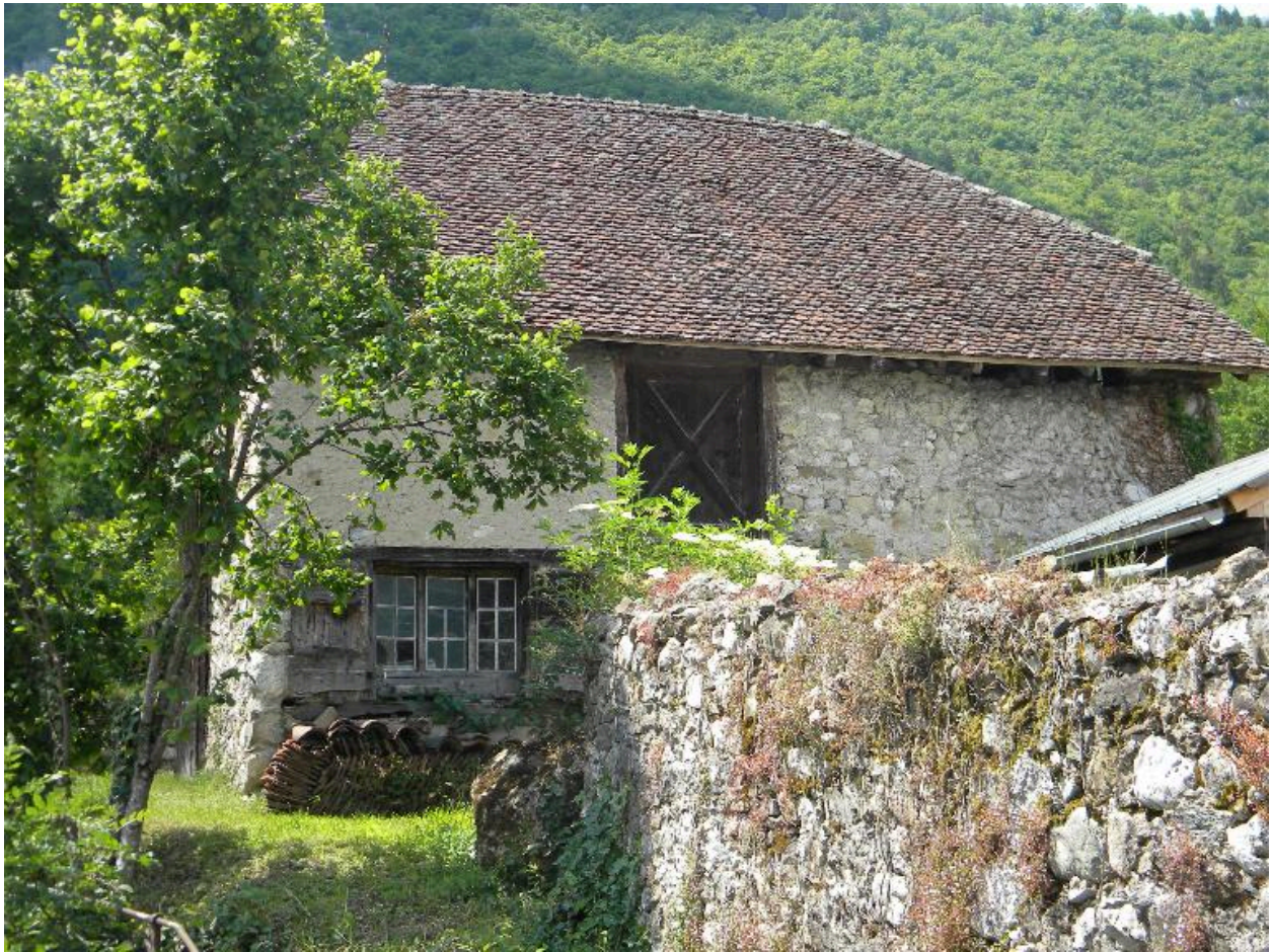
Vue de la façade est d'une ancienne forge (2008 B2 383).
