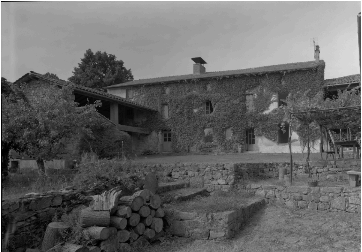
Vue d'ensemble de la façade antérieure.
