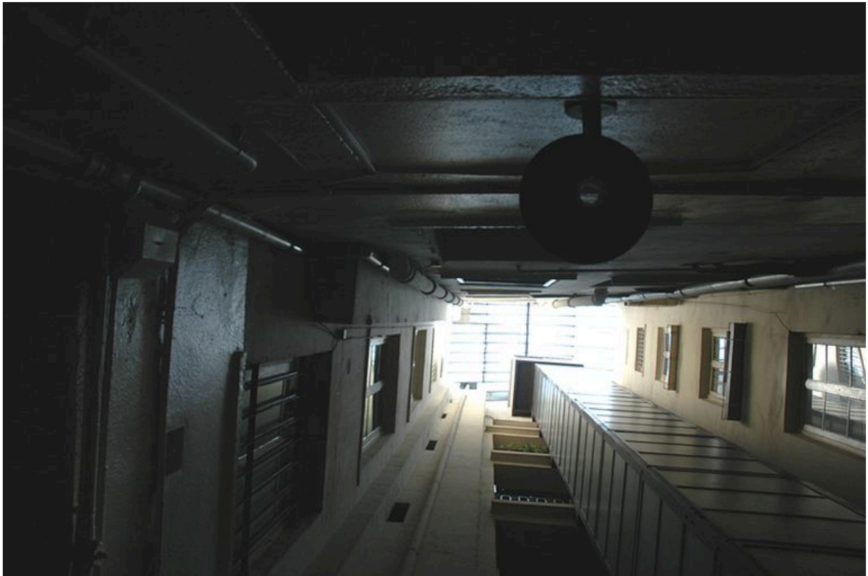
La cour en contre plongée
