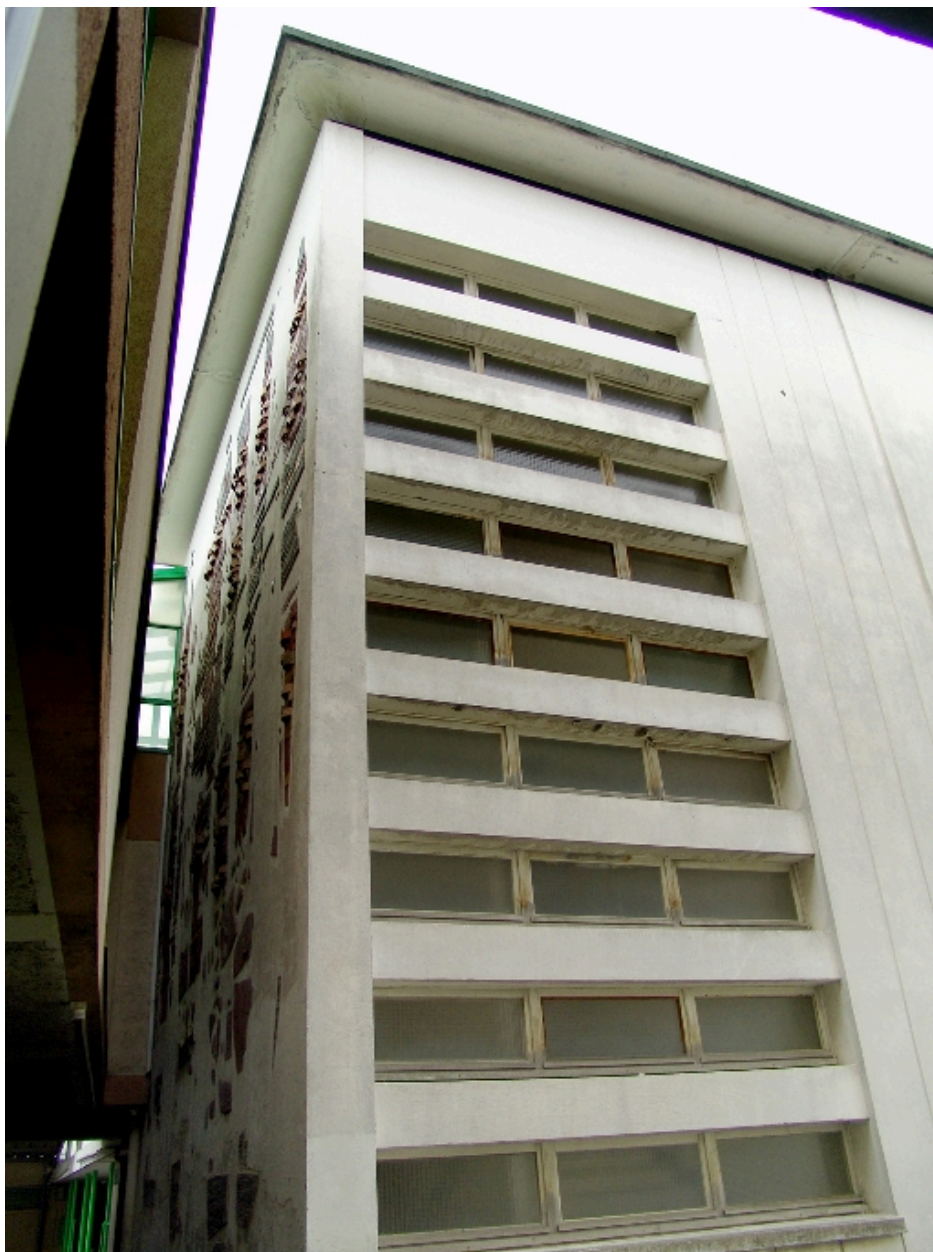
Bâtiment de 1962 : baies de la cage d'escalier
