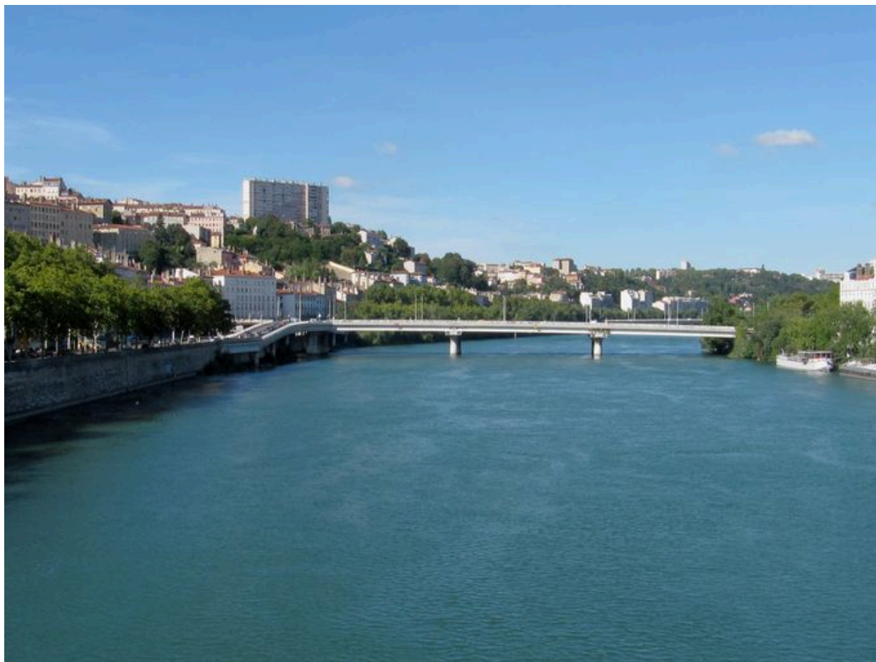
Vue générale, face aval (depuis le pont Morand)
