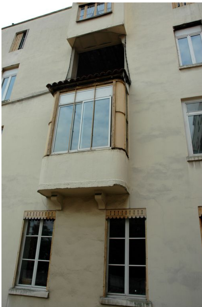
Détail des baies de l'élévation ouest
